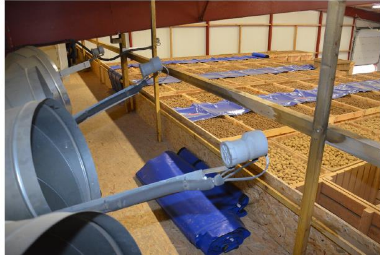
Sugventilasjon. Forbedring av luftfordeling i lagerrommet ved hjelp av rørbuer med høg lufthastighet.
