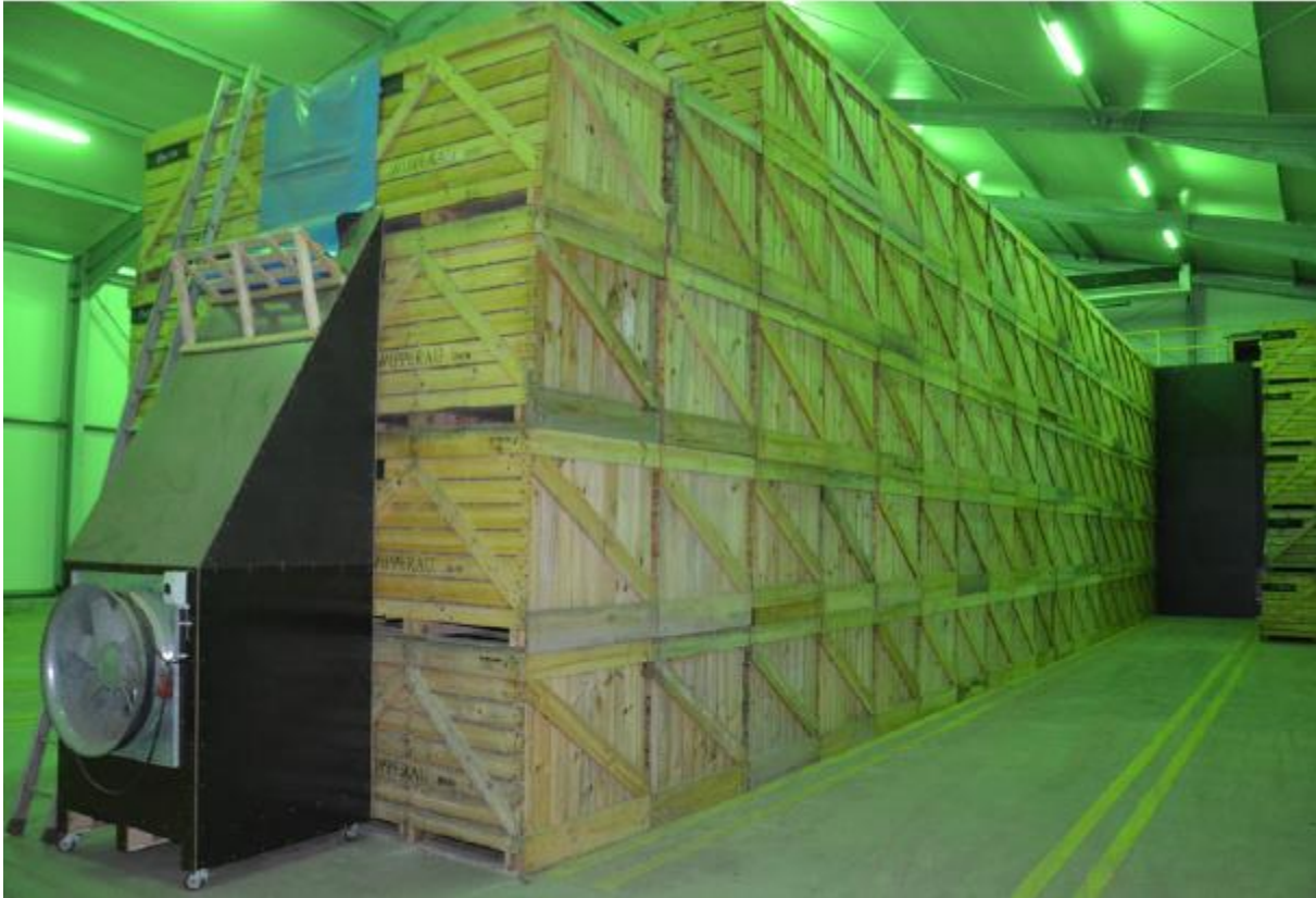
Sugventilasjon. Ekstra sugvifte ved enden av stabelen for å auke tørkekapasiteten
